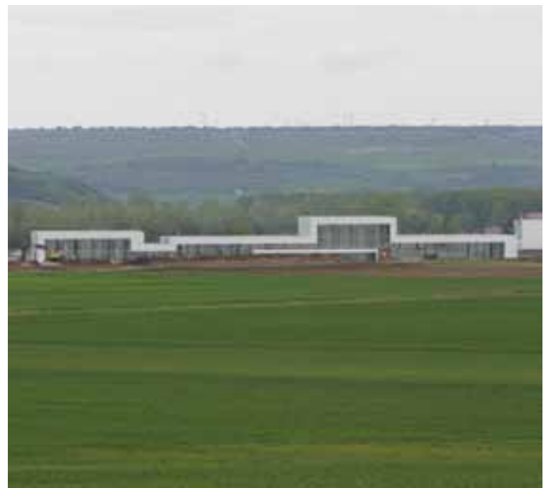
El centro de recepción pendiente. El Centro de Recepción de Visitantes de Ibeas se encuentra aún en fase de construcción.
