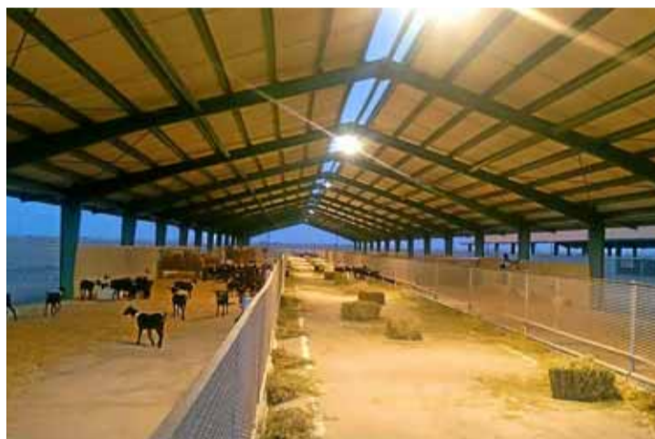
Explotación ubicada en Qhaleganj (Irán). / ACRIMUR
