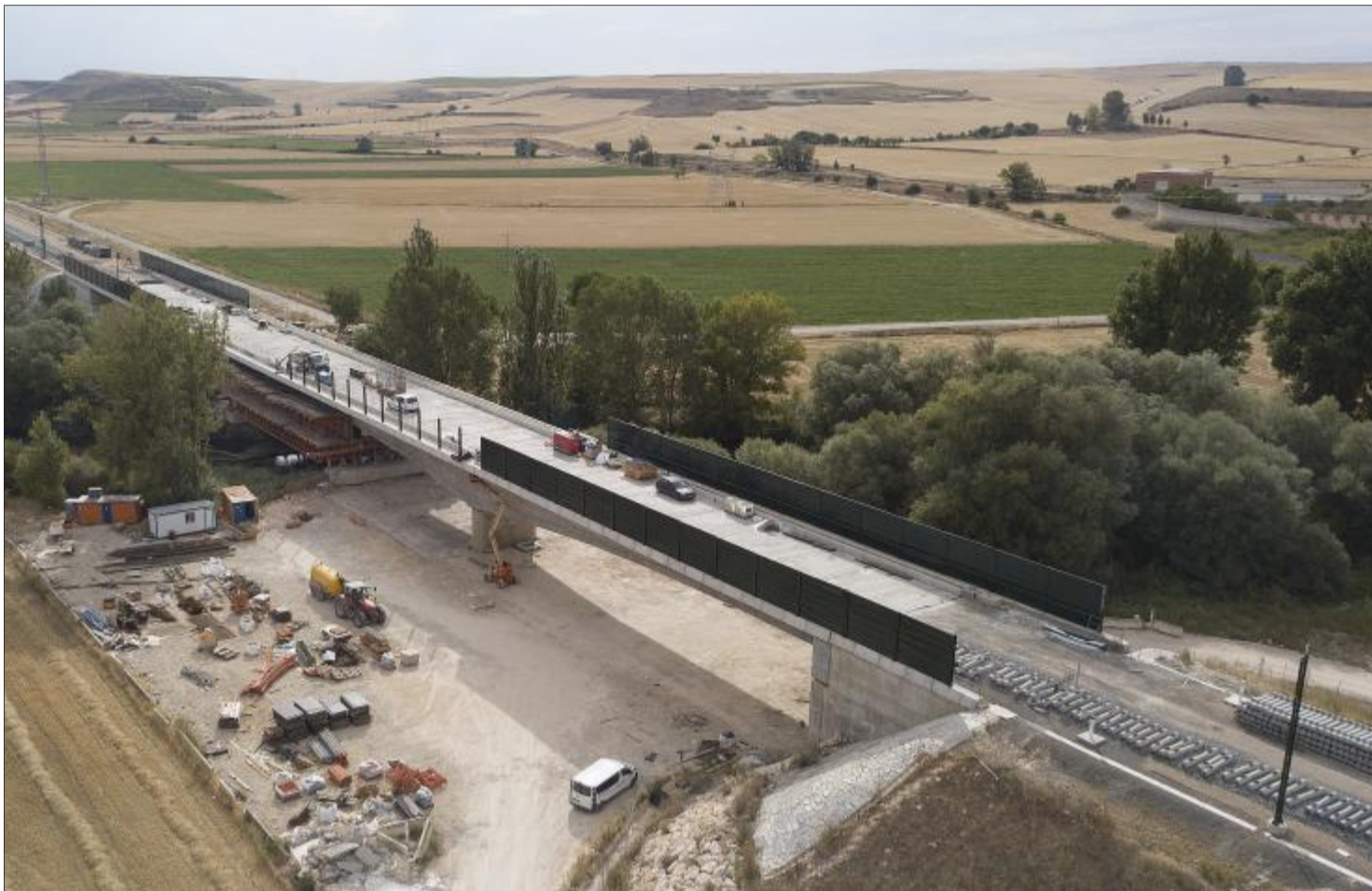
El tablero del viaducto del AVE sobre el Arlanzón está terminado, pero falta colocar las traviesas y vías, ya preparadas en el lado de Buniel. I. L. MURILLO
